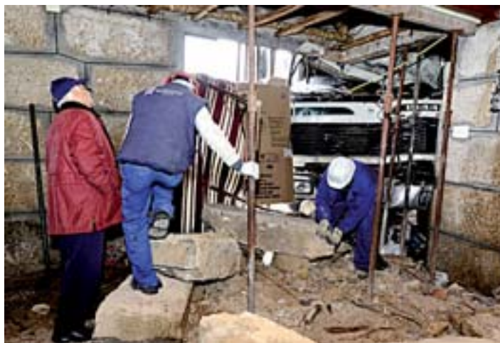
Un albanel traballa no interior da vivenda onde se encaixou o camión. > B. Lorenzo
